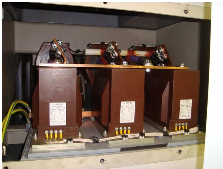
Slika 2.5: Mjerni transformatori napona i struje sinkronog generatora
