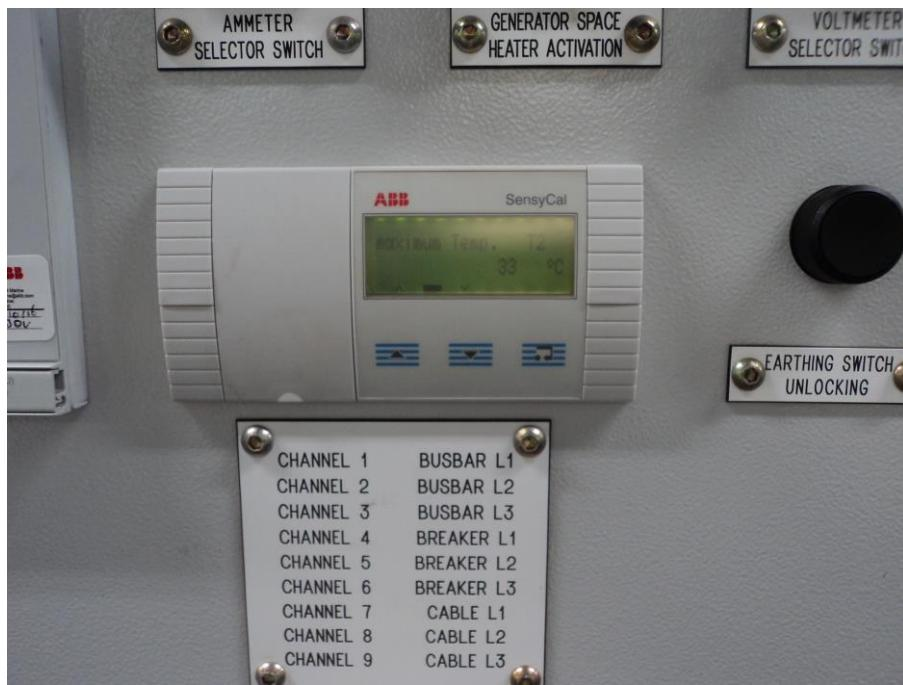
Slika 3.8: Nadzor temperature polja generatora glavne sklopne ploče
