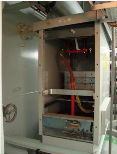
Slika 2.6: - Spoj zvjezdišta generatora na masu broda preko otpornika – (eng.: *Neutral Point Cubicle, NPC*)
