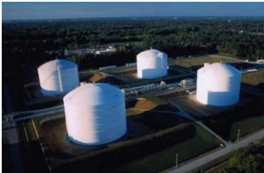
Slika 4. Lučki terminal za uplinjavanje LNG-a [7]
