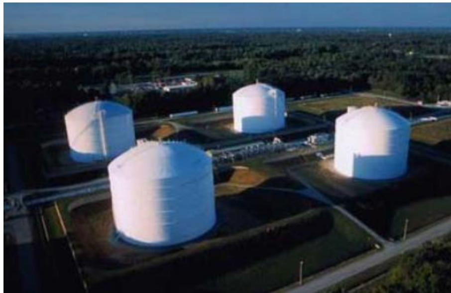
U lučkim terminalima za prihvatanje LNG-a prirodni ukapljeni plin obično se prebacuje u izolirane spremnike koji su posebno konstruirani za skladištenje LNG-a. Ti spremnici moraju održavati nisku temperaturu na kojoj se prevozi LNG i trebaju minimizirati količinu isparenog plina kako tlak i temperatura ne bi porasli u spremnicima. Ispušteni plin se može skupiti i koristiti kao
