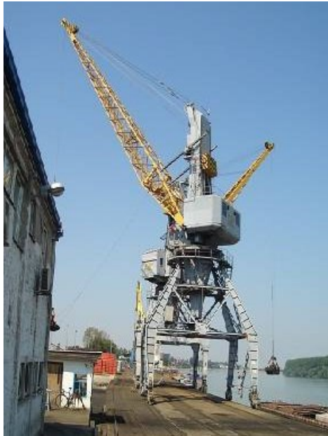
Slika 14. Dizalica s grabilicom
