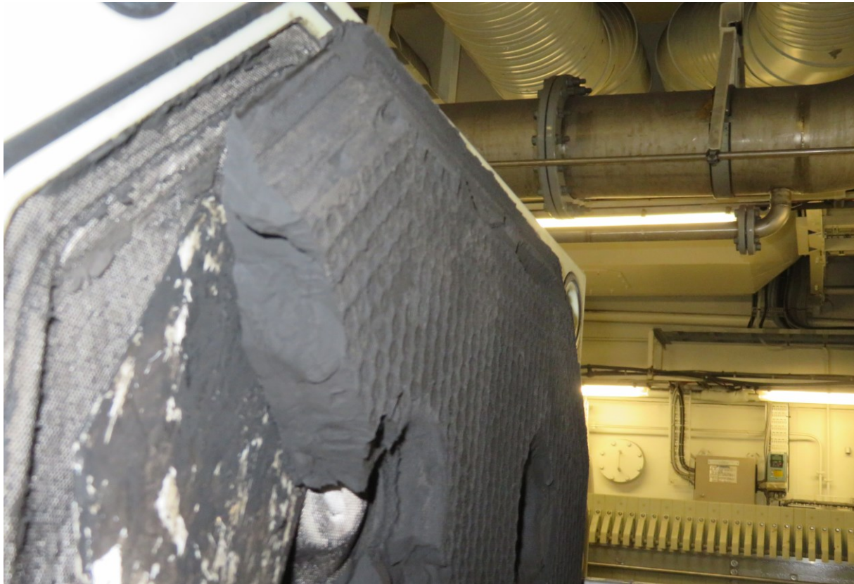
Slika 21. Mrežica uređaja za isušivanje sa nakupljenim krutim nečistoćama.[11]
