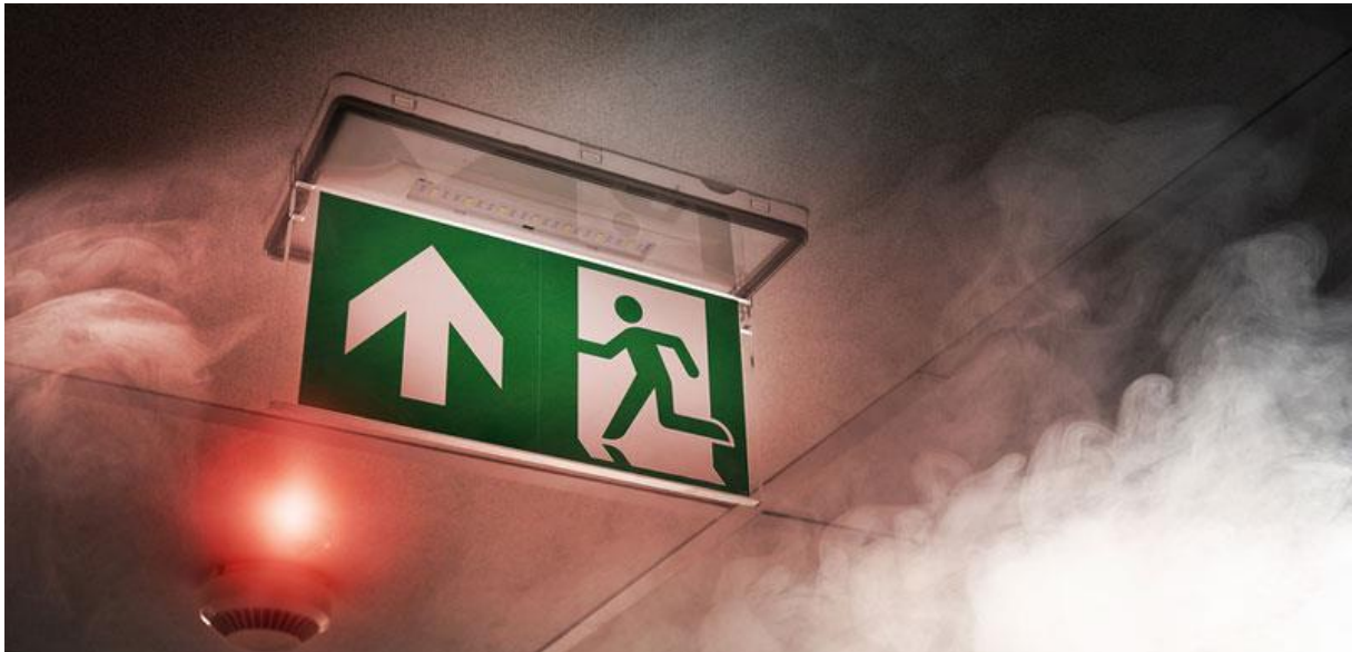
Slika 39. Alarm za nuždu koji daje upozorenja svjetlom i zvukom
