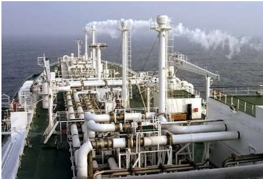
Slika 17. Cjevovod na LNG brodu [2]
