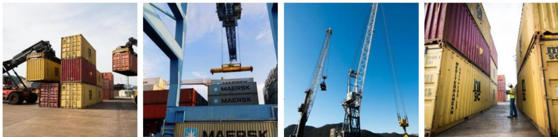
Slika 37: Terminal za kontejnerski teret, luka Ploče
