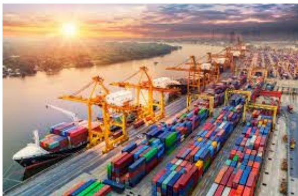
Slika 6. Moderno kontejnersko lučko postrojenje
