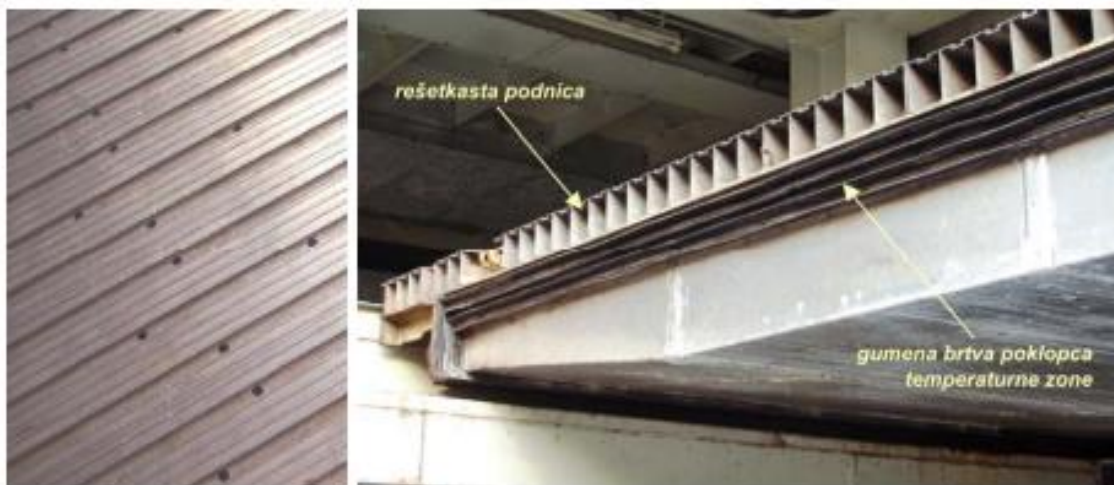
Slika 9. Rešetkaste podnice brodskih rashladnih skladišta 31
