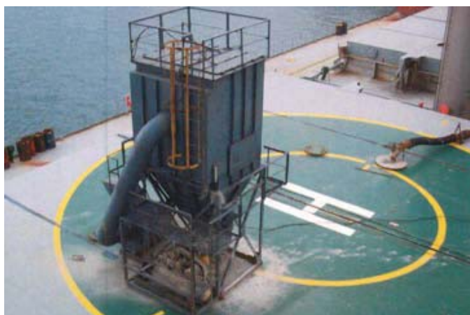
Slika 14. Ukrcaj cementa zatvorenim sustavom.
