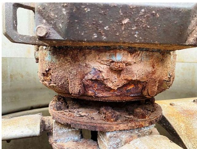
**Slika 34. Korozija impelera i elektromotora**
