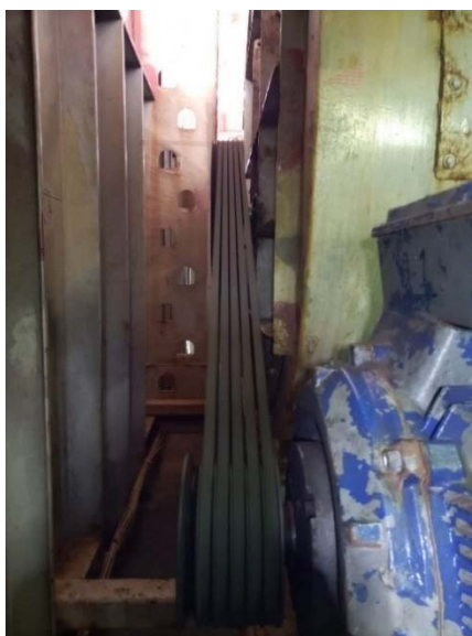
Slika 11. Ventilator s remenim prijenosom [5]
