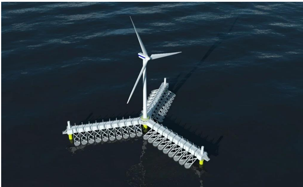
Slika 20. Wavestar Attenuator 81
