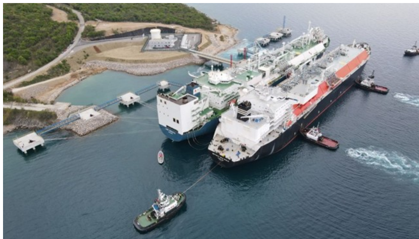
Slika 12. LNG terminal u Omišlju na otoku Krk u pripremi iskrcajnih operacija sa tankerom.
