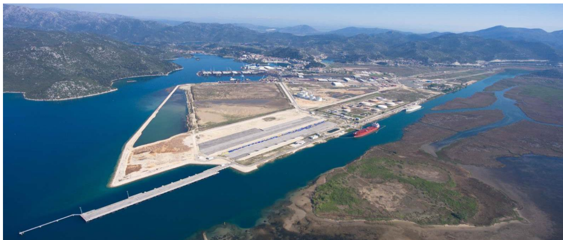
Slika 5. Pogled na terminale Luke Ploče
