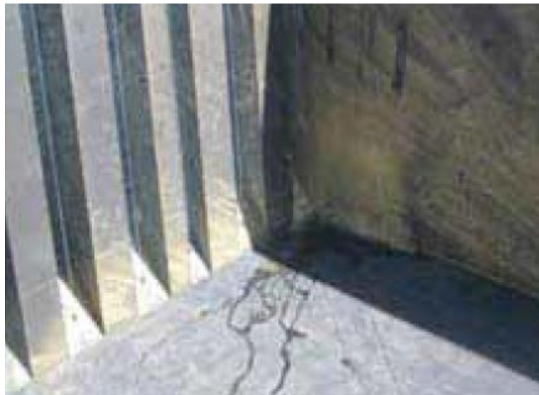
Slika 41. Prodor vode kroz kaljužni ventil
