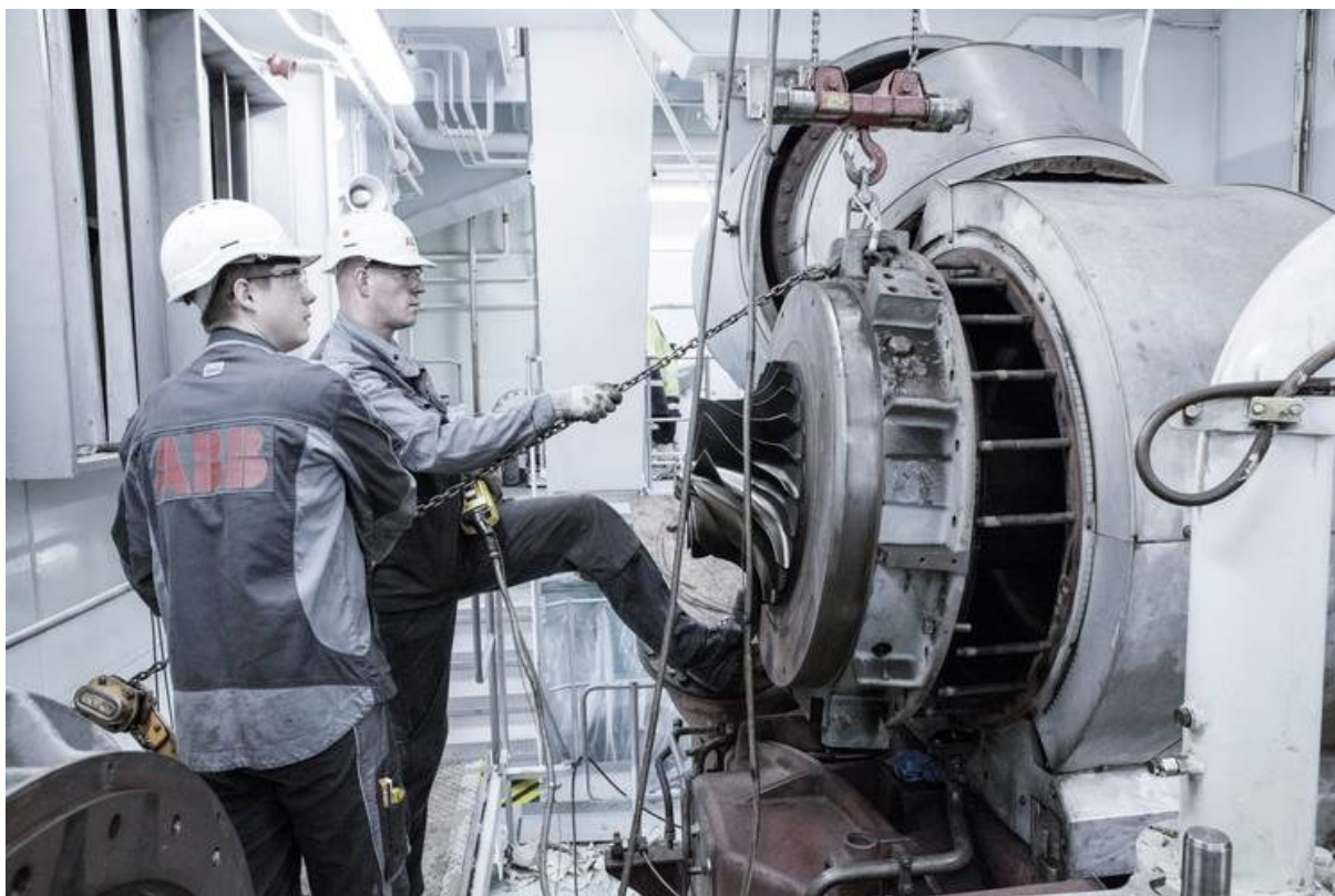
Slika 17. Turbopuhalo u remontu [27]
