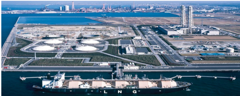
Slika 2. Postrojenje za obradu prirodnog plina [16]
