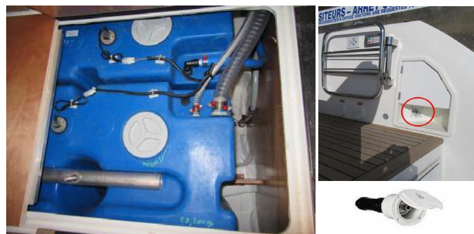
Slika 27. Tank vode i priključak vodu s kopna [3]
