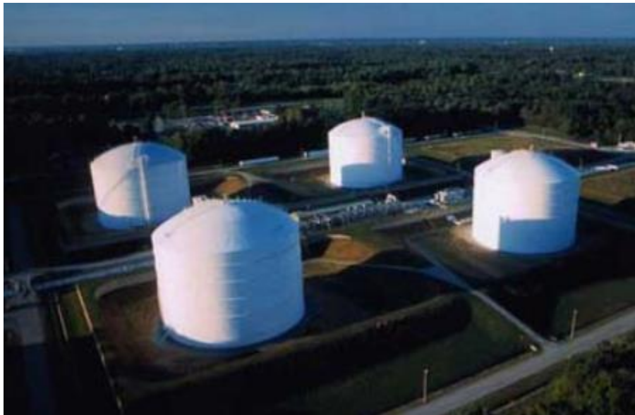
Slika 4. Lučki terminal za uplinjavanje LNG-a [7]
