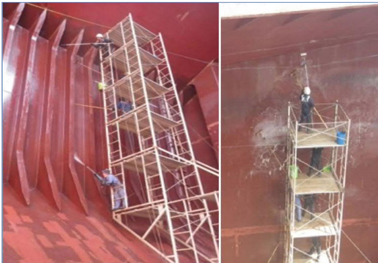
Slika 12. Čišćenje teško dostupnih mjesta brodskih skladišta pomoću sklopive platforme
