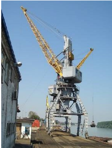
Slika 14. Dizalica s grabilicom
