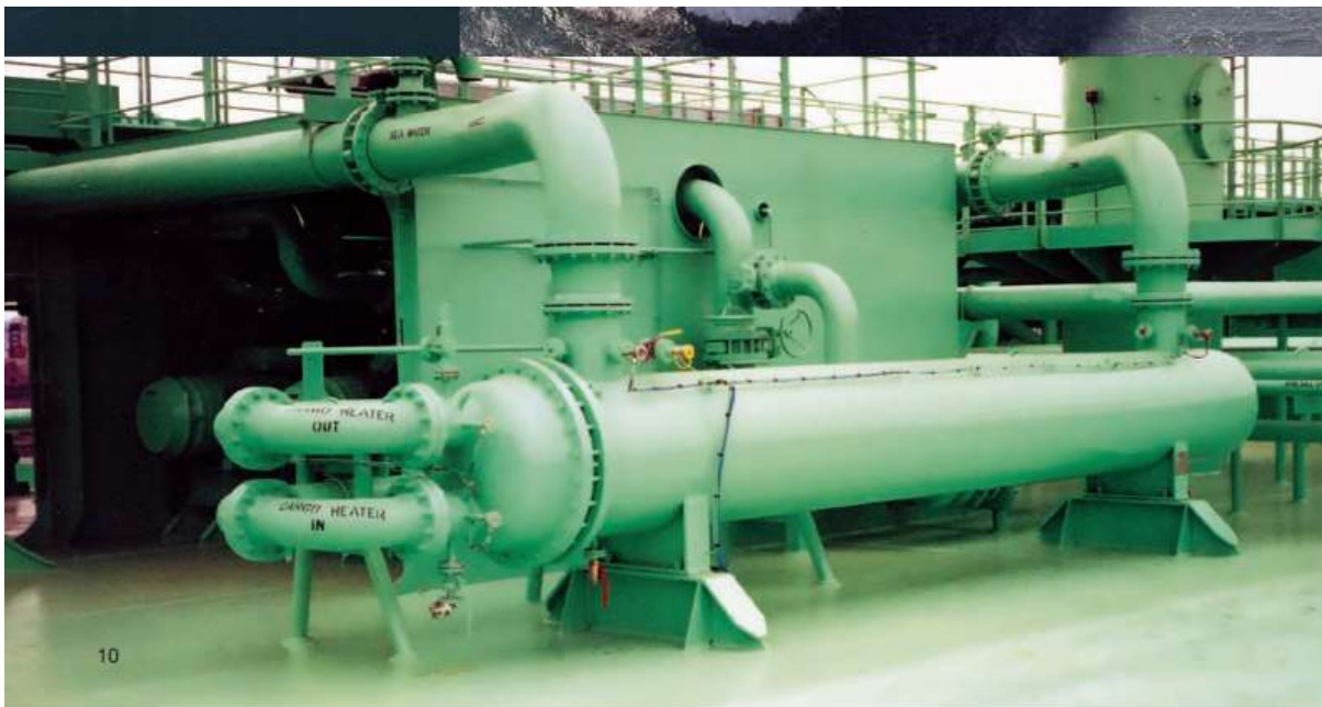
Slika 16. Izmjenjivač topline [18]
