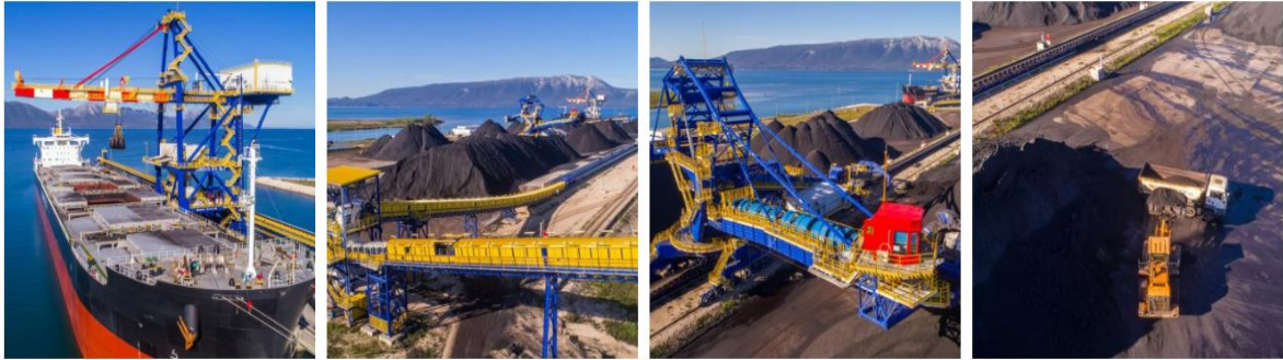
Slika 36: Novi terminal rasutog tereta, luka Ploče
