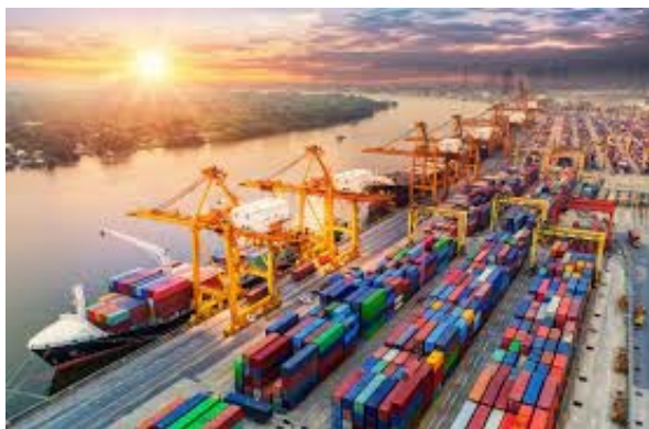
Slika 6. Moderno kontejnersko lučko postrojenje
