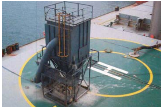
Slika 14. Ukrcaj cementa zatvorenim sustavom.
