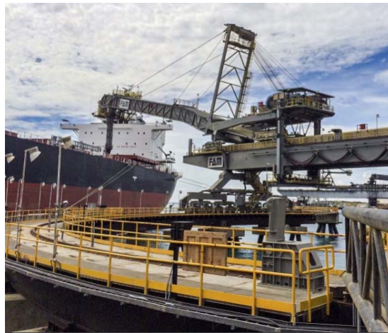
Slika 24. Radijalno ukrcajno postrojenje.
