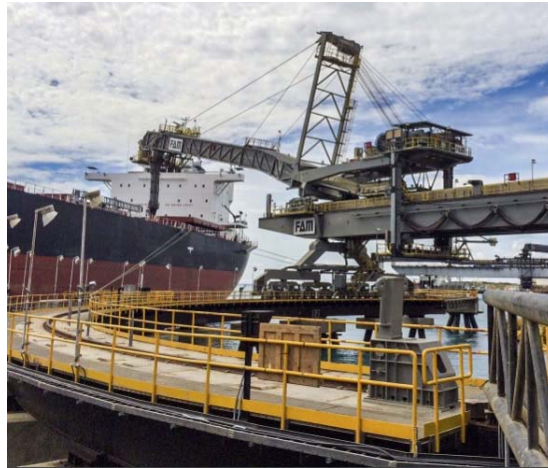
Slika 24. Radijalno ukrcajno postrojenje.
