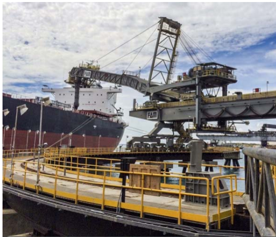
Slika 24. Radijalno ukrcajno postrojenje.
