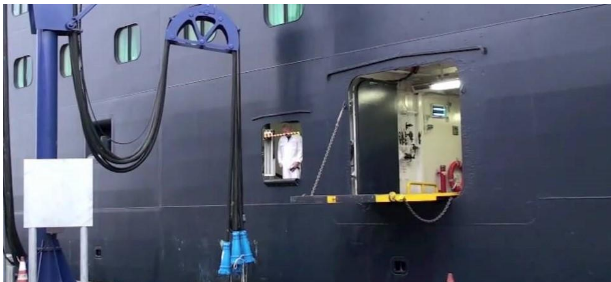
Slika 11. Priprema broda za spajanje na kopneni priključak[12]
