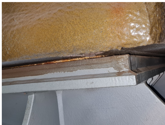
Slika 9. Spremnik tereta oslanja se na brodsku konstrukciju; Izvor: arhiva autora
