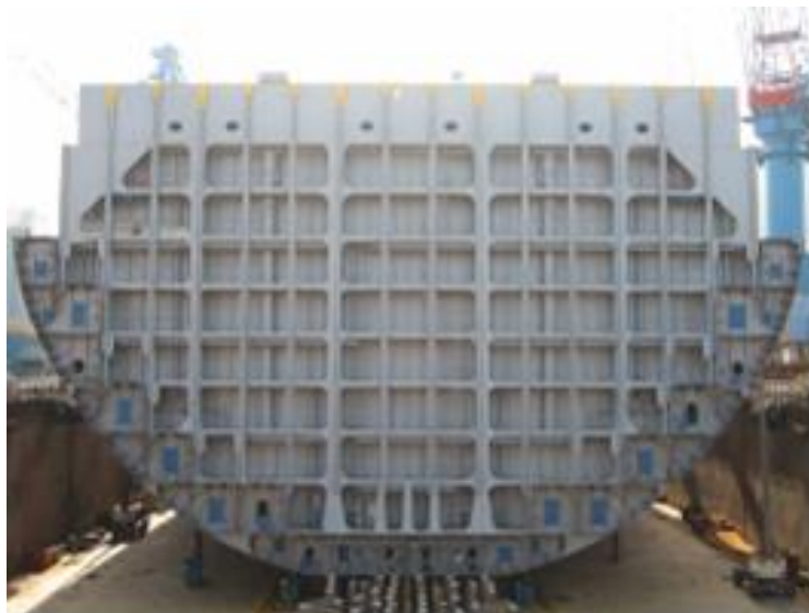
Slika 4.: Vodonepropusne pregrade [7b]
