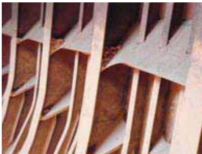
Slika 13. Ostaci prijašnjeg tereta rudaće, zaglavljanim u rebrima
