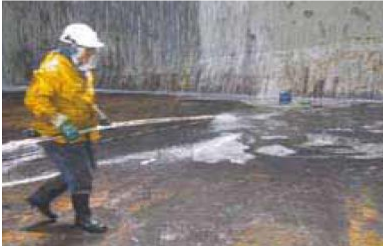
Slika 35. Nanošenje kemikalija
