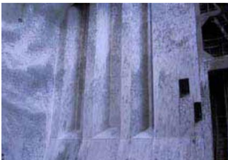
Slika 30. Nanošenje kemikalija (prewash)
