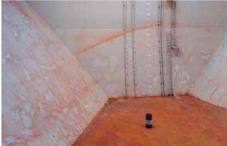
Slika 10. Skladište sa mrljama od boksita
