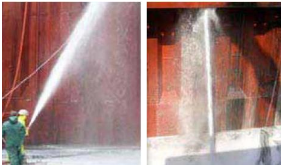
Slika 26. Pranje gornjih dijelova skladišta
