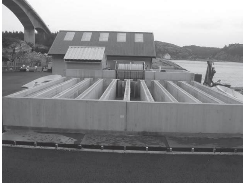
Slika 8. Stvarni prikaz protočnog sustava u rastilištu za češljače (Izvor: Magnesen i Christophersen, 2007)
