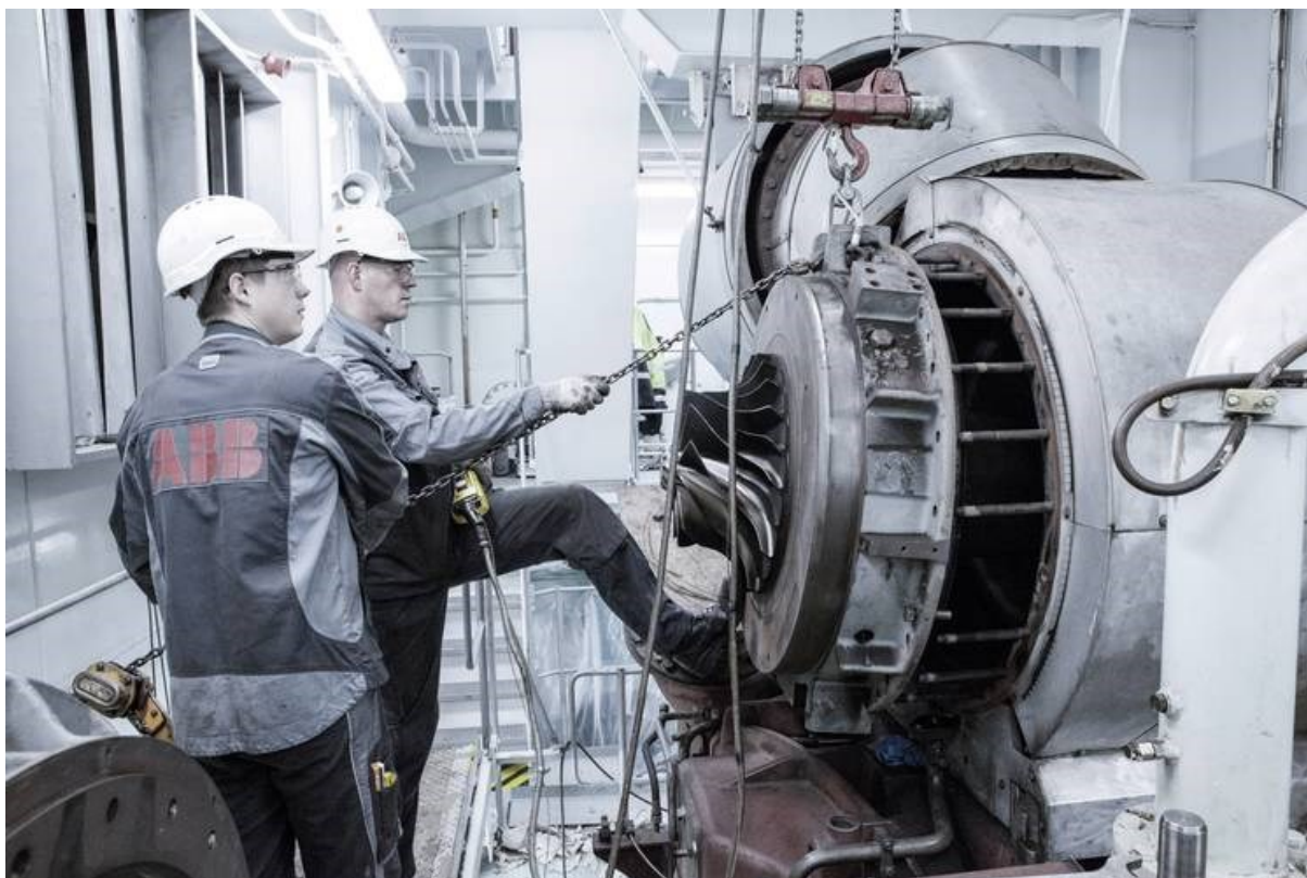
Slika 17. Turbopuhalo u remontu [27]
