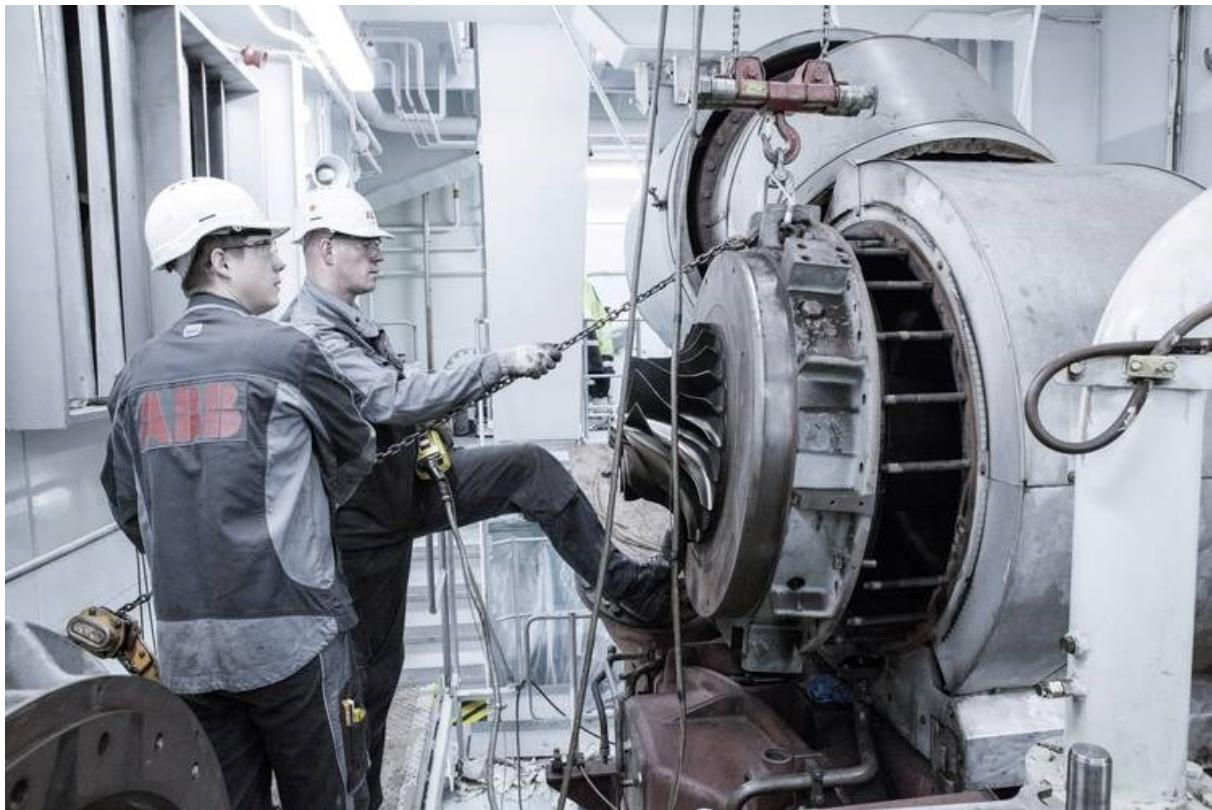
Slika 17. Turbopuhalo u remontu [27]
