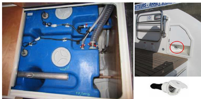
Slika 27. Tank vode i priključak vodu s kopna [3]
