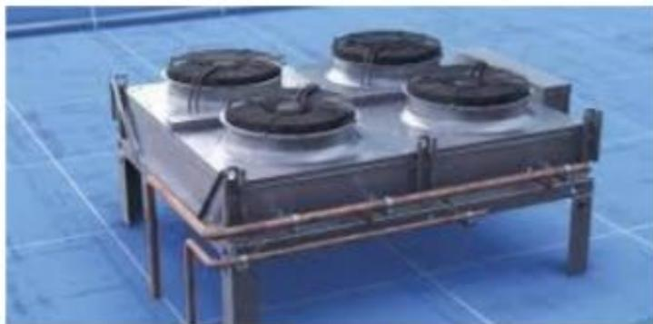
**Slika 15. Kondenzator s orebrenim cijevnim sekcijama [14]**
