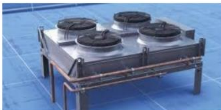
Slika 15. Kondenzator s orebrenim cijevnim sekcijama [14]
