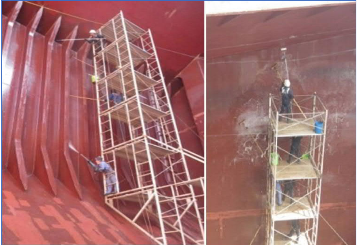
Slika 12. Čišćenje teško dostupnih mjesta brodskih skladišta pomoću sklopive platforme
