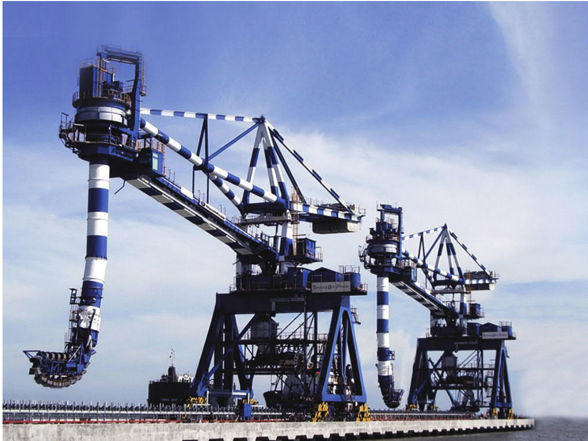
Slika 8. Suvremena lučka postrojenja za iskrcaj rasutih tereta velikih kapaciteta
