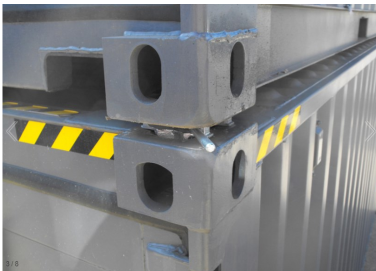
Slika 11. Prikaz pravilnog učvršćivanja zakretne brave
