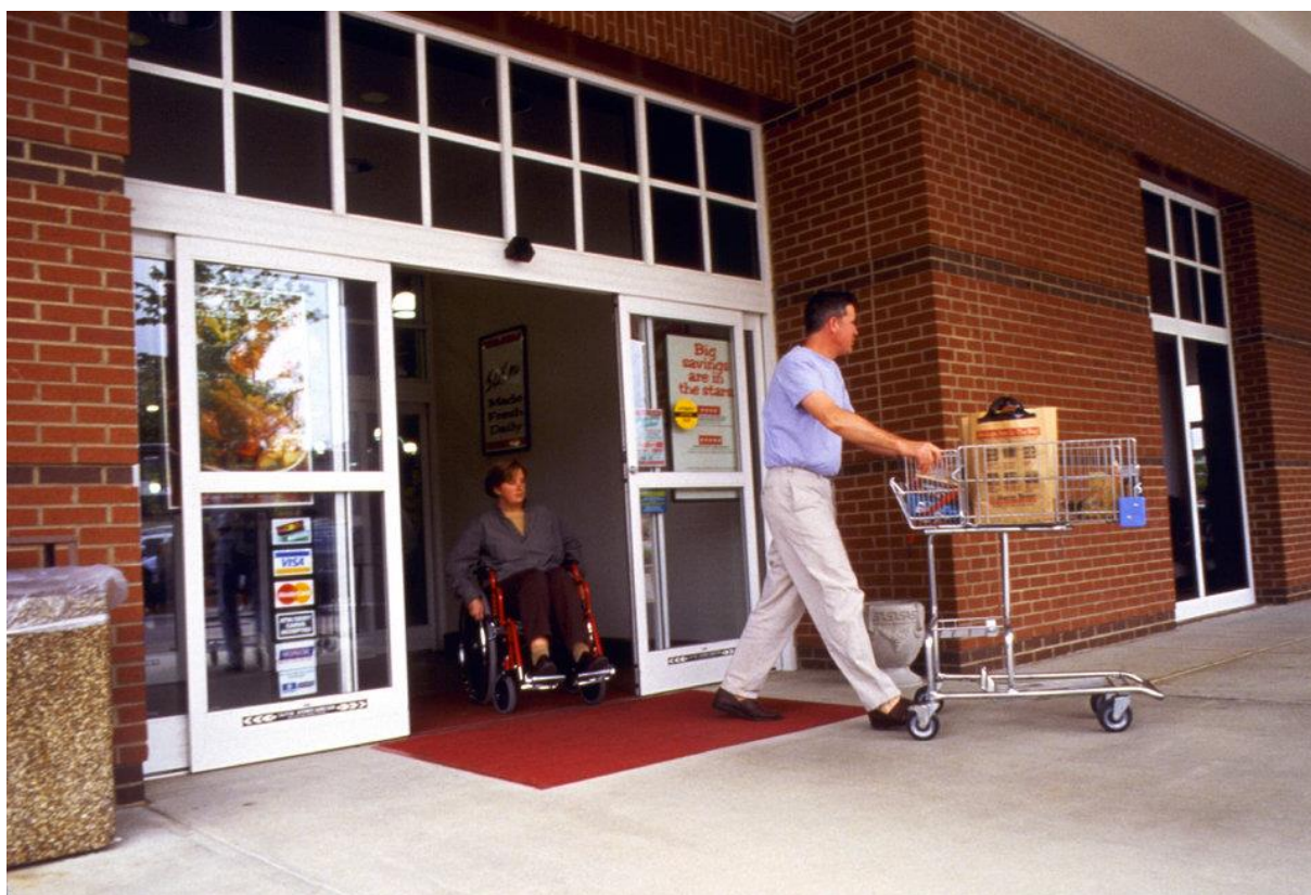
Slika 34. Slika automatskih vrata kao primjer 1. načela univerzalnog dizajna
