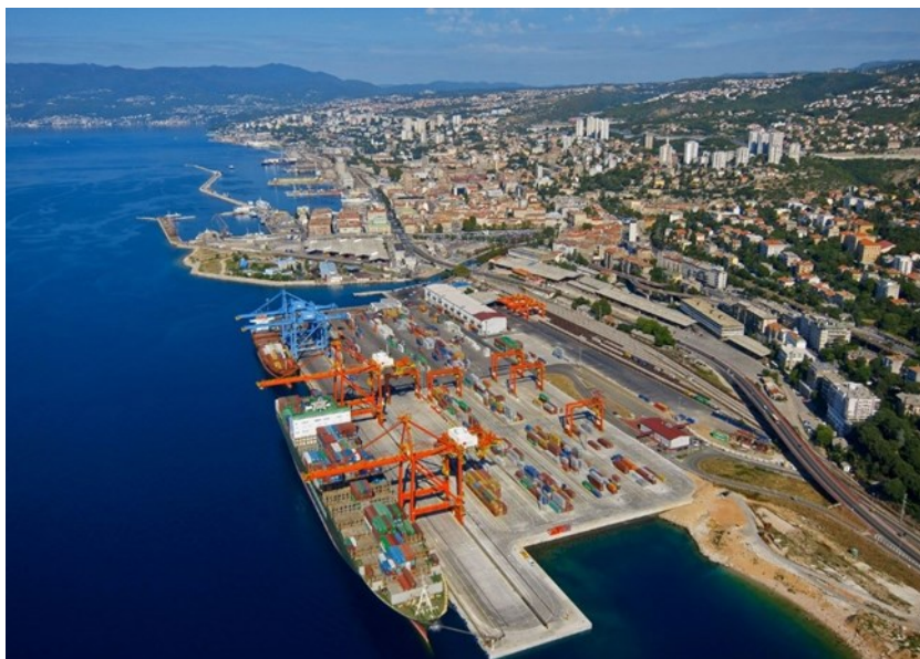
Slika 4. Terminal Jadranska vrata, najveći kontejnerski terminal u Hrvatskoj.
