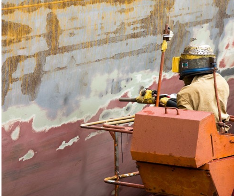
Slika 11. Pjeskarenje- Suha priprema broskog trupa; Izvor [11]
