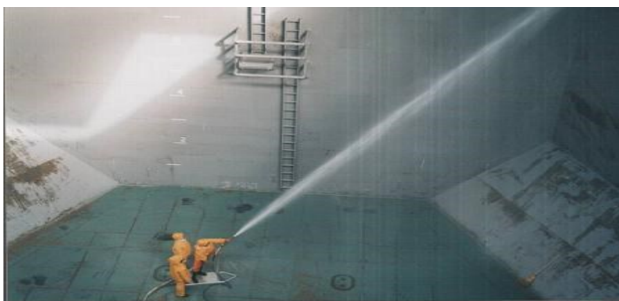
Slika 16. Pogled na čišćenje broskog tanka u zaštitnim odijelima; Izvor [16]
