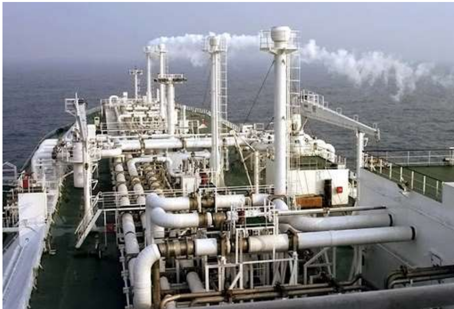
Slika 17. Cjevovod na LNG brodu [2]
