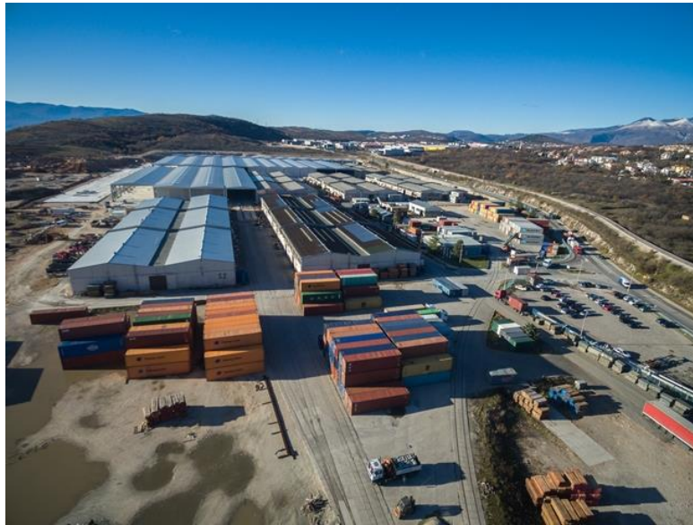
Slika 3: Kontejnerski terminal, Škrljevo, luka Rijeka
