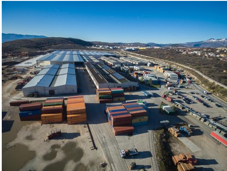
Slika 3: Kontejnerski terminal, Škrljevo, luka Rijeka
