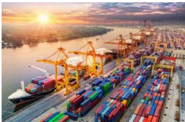
Slika 6. Moderno kontejnersko lučko postrojenje
