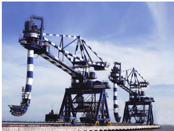
Slika 22. Suvremena lučka postrojenja za iskrcaj suhih rasutih tereta velikih kapaciteta.
