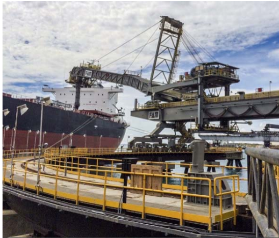
Slika 24. Radijalno ukrcajno postrojenje.
