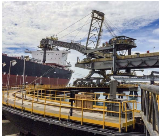
Slika 24. Radijalno ukrcajno postrojenje.
