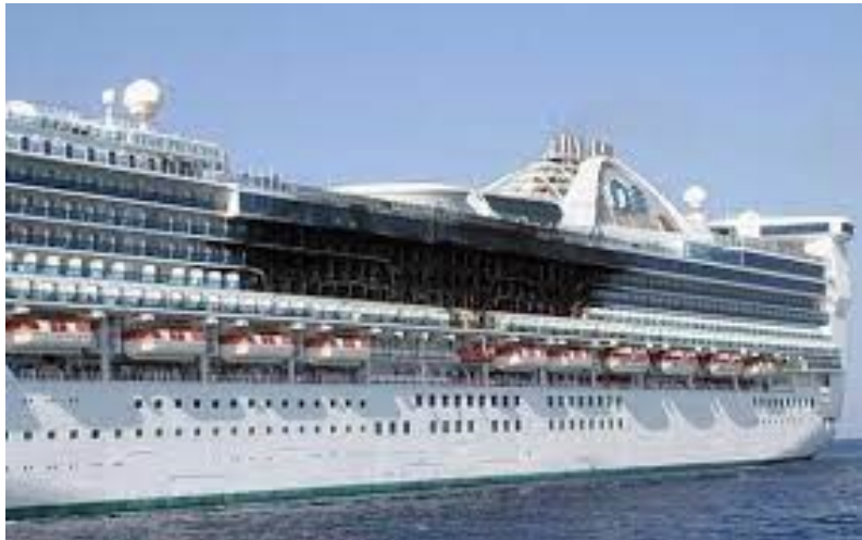
Slika 4. Star Princess nakon požara.
