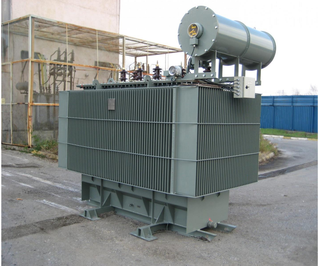
Slika 12. Uljni transformator [20]
