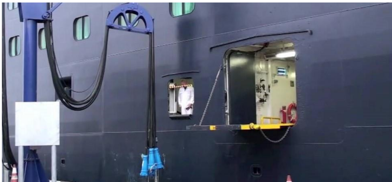
Slika 11. Priprema broda za spajanje na kopneni priključak[12]
