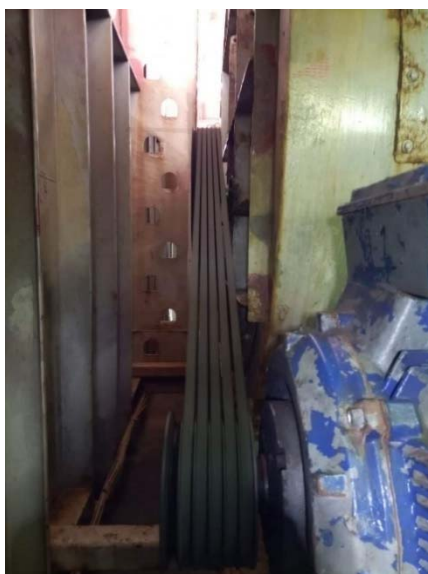
Slika 11. Ventilator s remenim prijenosom [5]
