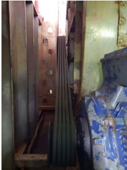
Slika 11. Ventilator s remenim prijenosom [5]
