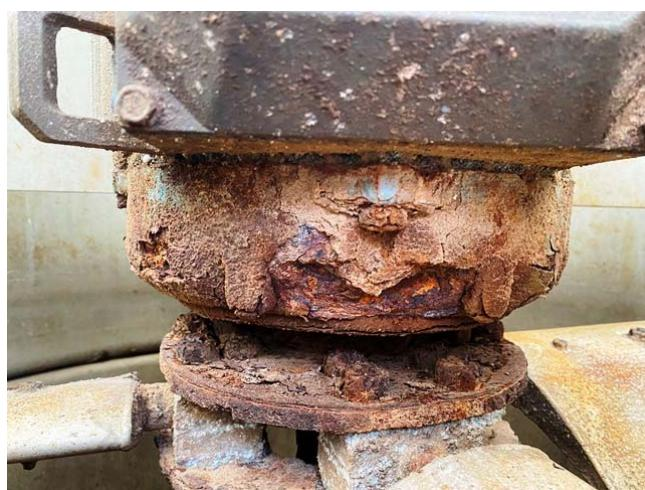
**Slika 34. Korozija impelera i elektromotora**
