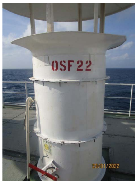
Slika 49. Klapna u slučaju požara obojana crvenom bojom
