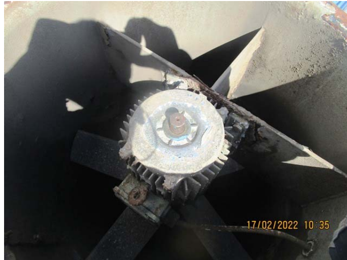
Slika 9. Aksijalni ventilator
