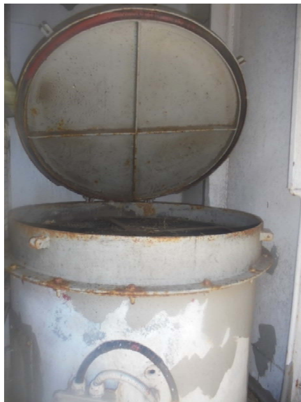
Slika 17. Prikaz ventilatora za strojarnicu
